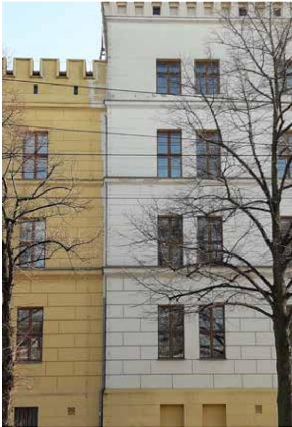
Das Kreiswehrrersatzamt Potsdam (links im Bild) wurde im Jahr 1992 mit KEIM Silikatfarbe gestrichen (Farbton 9071); rechts wurde 1995 im selben Farbton mit organisch pigmentierter Farbe eines Wettbewerbers gestrichen – mit deutlicher sichtbarer Farbtonveränderung!
