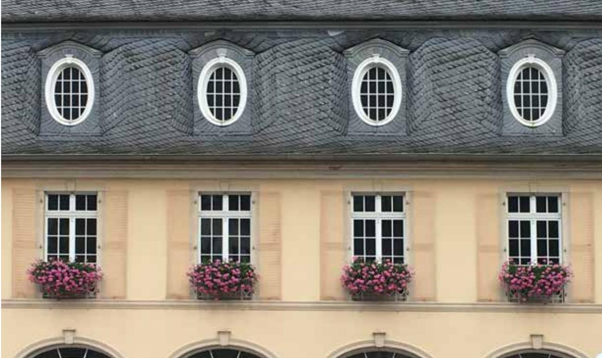
Fassade mit deutlich sichtbaren Farbtonveränderungen in den Bereichen demontierter Fensterläden.
