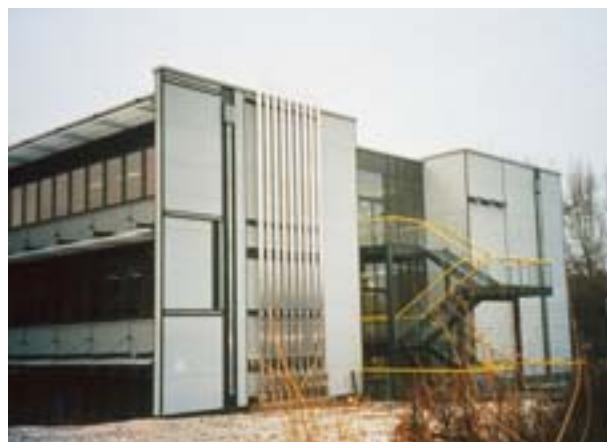
Das neu erbaute Laborgebäude besteht aus zwei Trakten mit einer Mittelspange zur Aufnahme der Erschließung und Versorgung.
