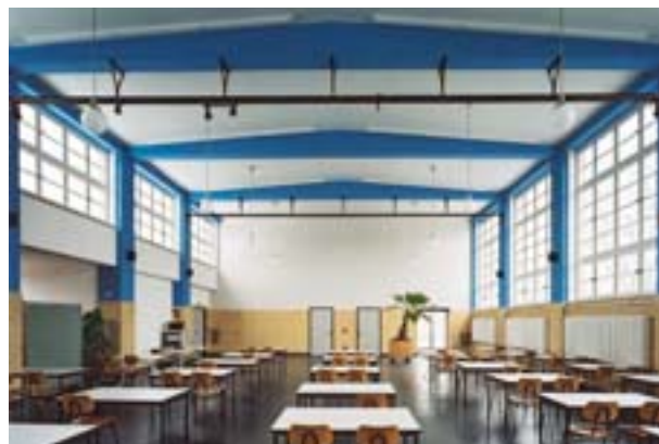
In der einstigen Doppelturnhalle befindet sich jetzt die Cafeteria der Schule. Bei der Instandsetzung stellte man die originale Farbigkeit wieder her.
